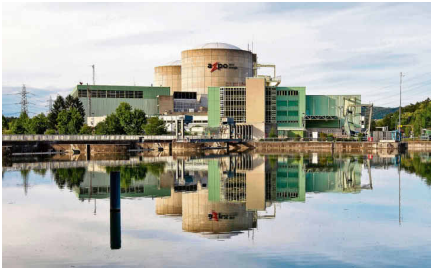
Umstrittene Kernkraft: Die Elektrizitätswerke des Kantons Zürich beziehen auch Strom aus dem Atomkraftwerk Beznau. Keystone
